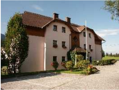
(Wohnhaus Neue Heimat - Haus A)
