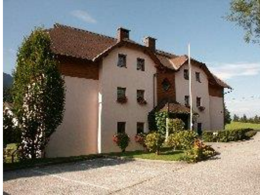
(Wohnhaus Neue Heimat - Haus A)
