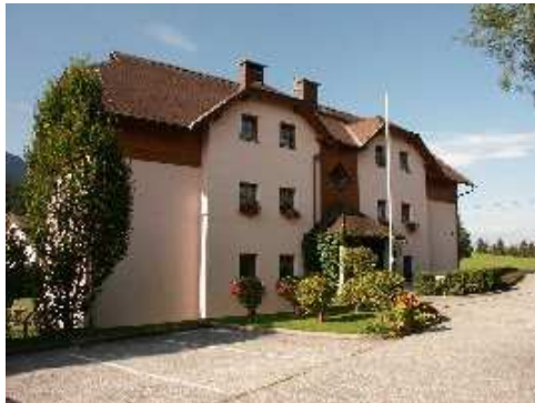
(Wohnhaus Neue Heimat - Haus A)
