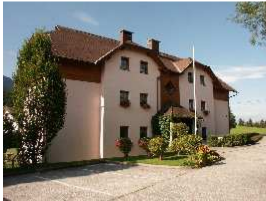
(Wohnhaus Neue Heimat - Haus A)
